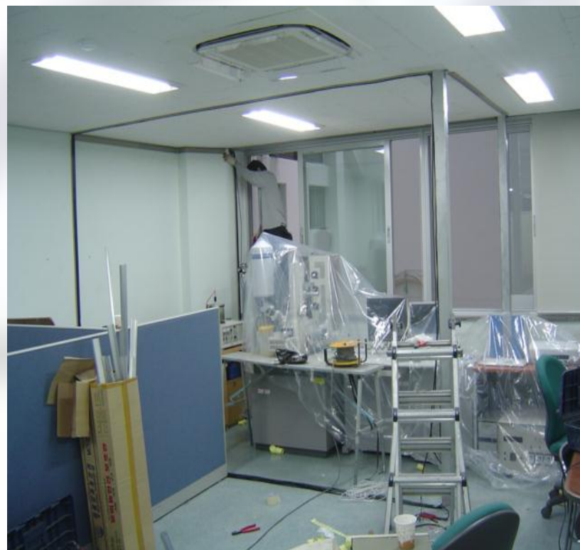
設置された相殺コイル
